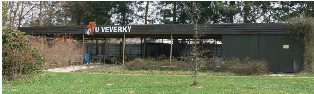
Obr. 12 Současný stav stavby „U veverky“
