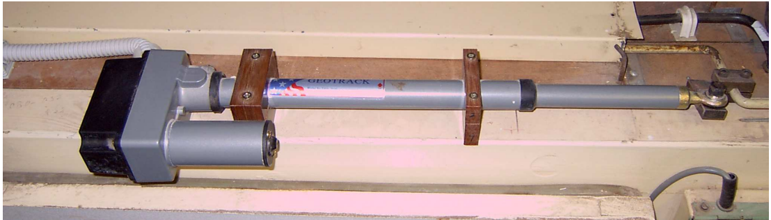
Obr. 35. Umístění a mechanické spojení servopohonu AG MINI s klapkou vzduchotechniky.
