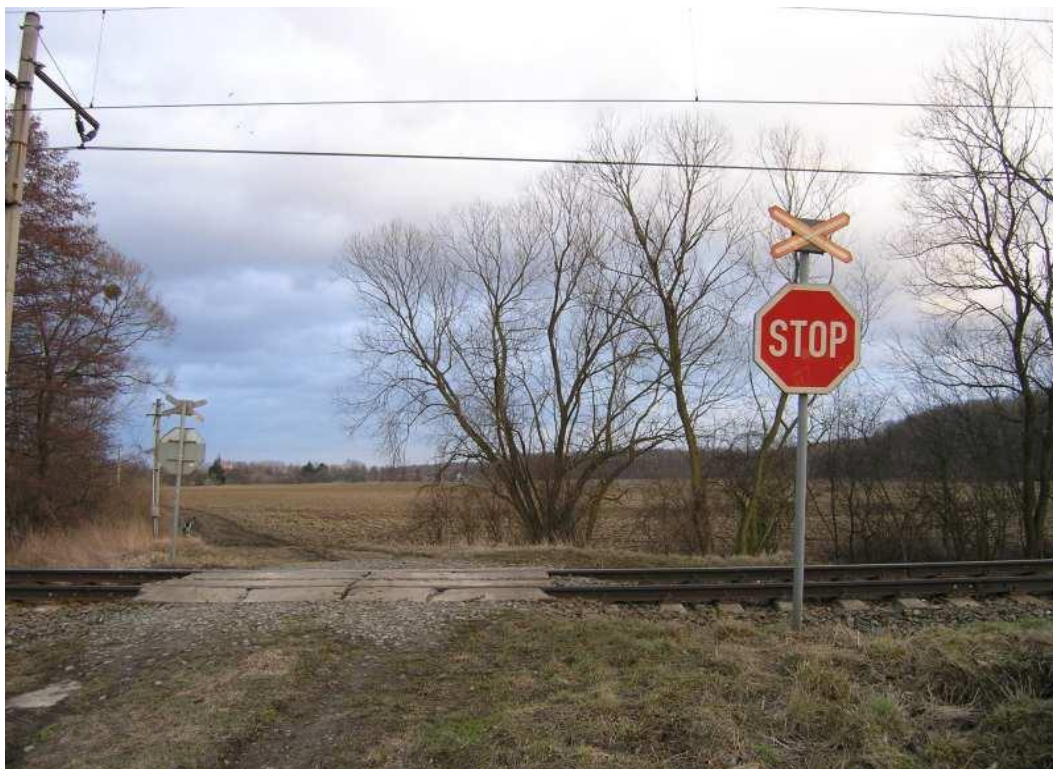
Obr. 4. Železniční přejezd s výstražným křížem
