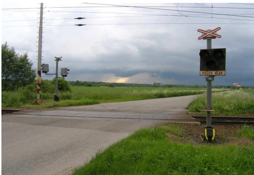
Obr. 7. Přejezd se světelnou signalizací
