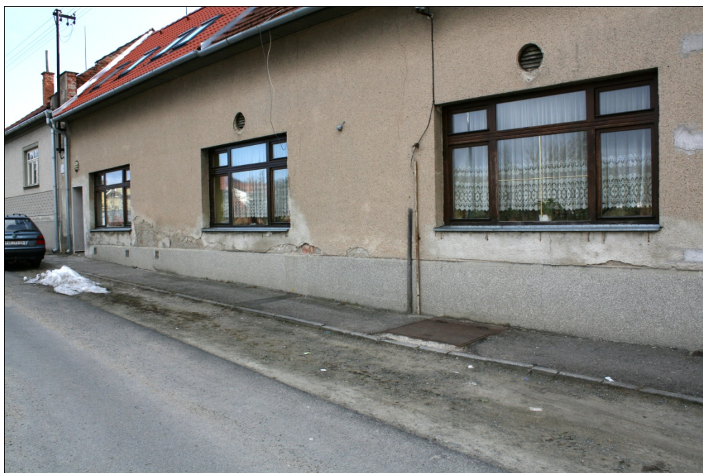
Obrázek 30 - 3. Pohled na levou část budovy s okny výčepu, která nenesou stopy páčení. [13]
