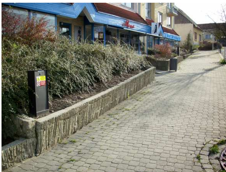
Obr. 40. Zídky, keře a el. rozvodny před obchody
