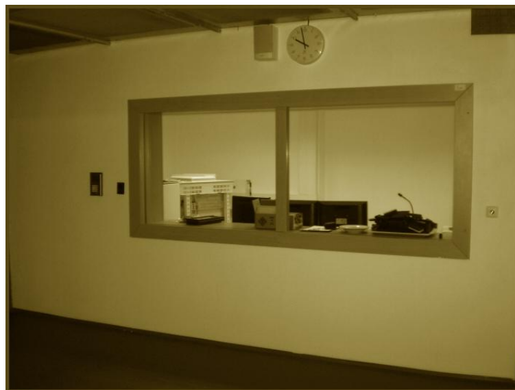
Obrázek 56. Pohled z tunelu na velín
