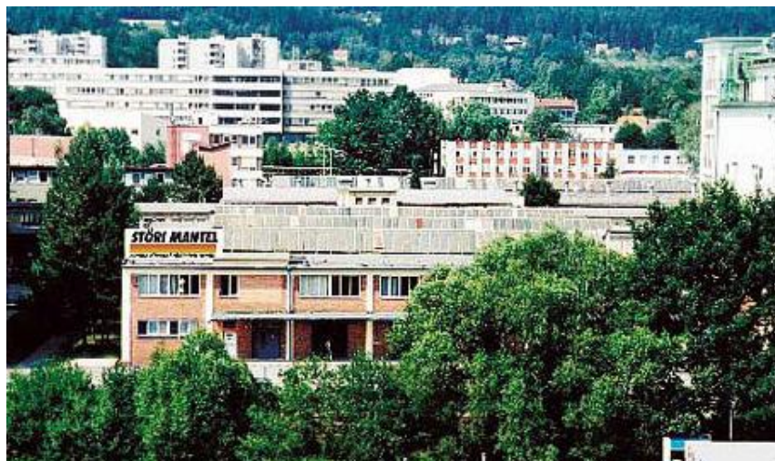
Obr. 10. Výrobní závod společnosti Störi Mantel s.r.o.
