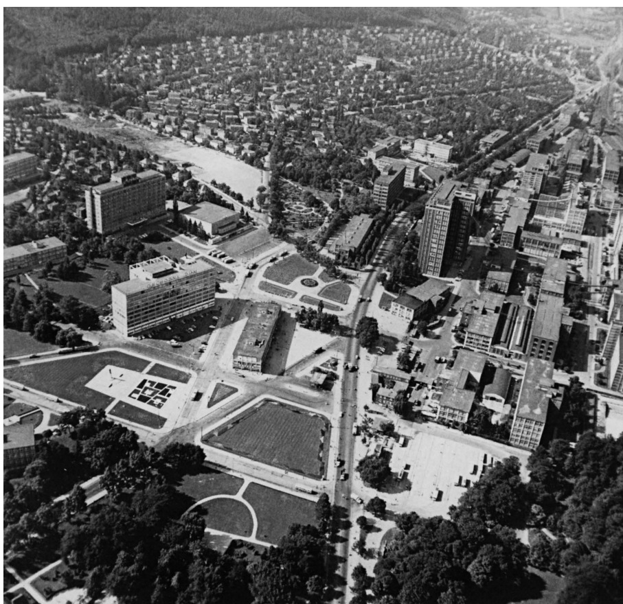
Fot. 4/9, Letecký pohled na prostor náměstí Práce. Snímek vyfotografovaný při průletu nad zámekem dokumentuje vztah průmyslové, obytné a společenské části města. [1, s. 220]
