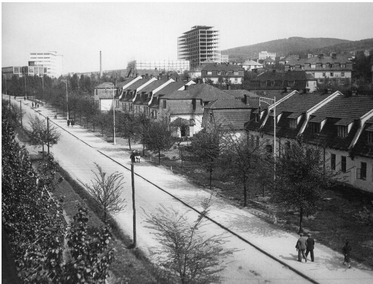
Fot. 2/12, Pohled od továrny na Letnou a nové centrum, 1932. [4, s. 29]
