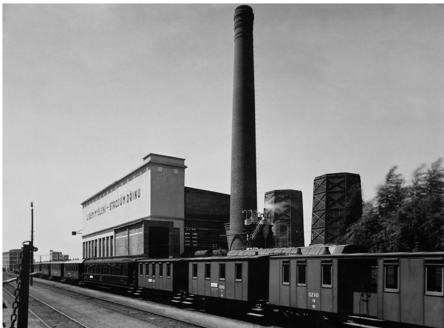
Fot. 2/20, Starý komín a elektrárna s dřevnými chladicími věžemi, 1910-20. Stěnu elektrárny zdobí nápis: „Lidem myšlení, strojům dřinu.“ Středová kompozice podtrhuje důležitost komínu, ubíhající koleje s vagóny spojení Zlína se světem. [MZA, Inv.č. 191]
