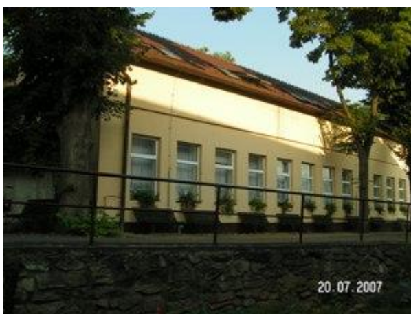
Část budovy domova
