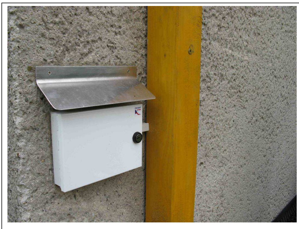
PI. 8 Nainstalovaná klávesnice v ochranném krytu na východní straně
