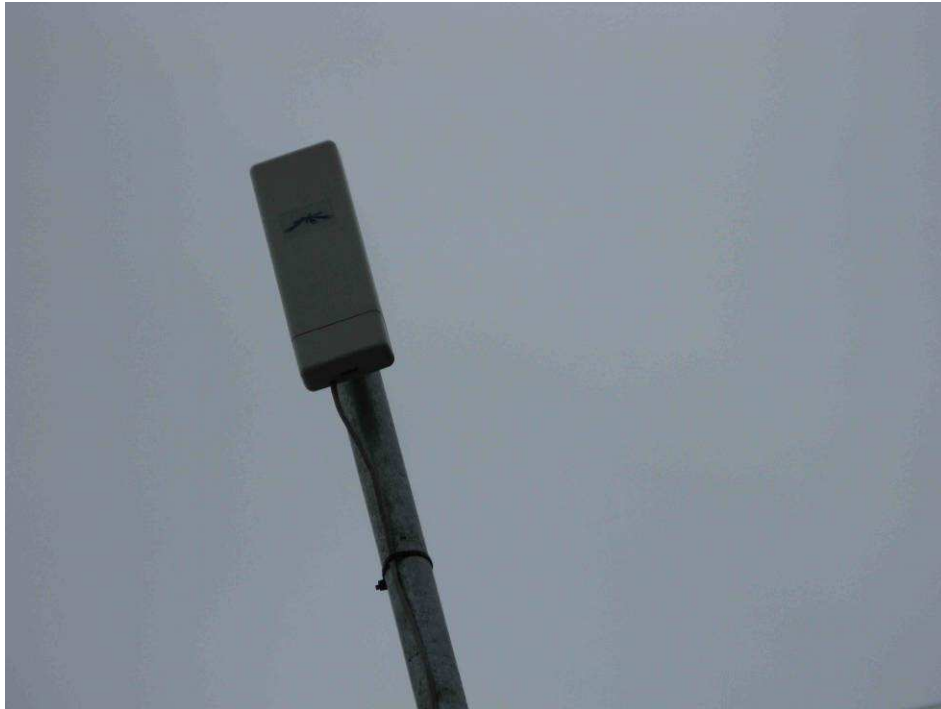
Obr. č. 20 Panelová anténa pro připojení do WiFi sítě na výložníku
