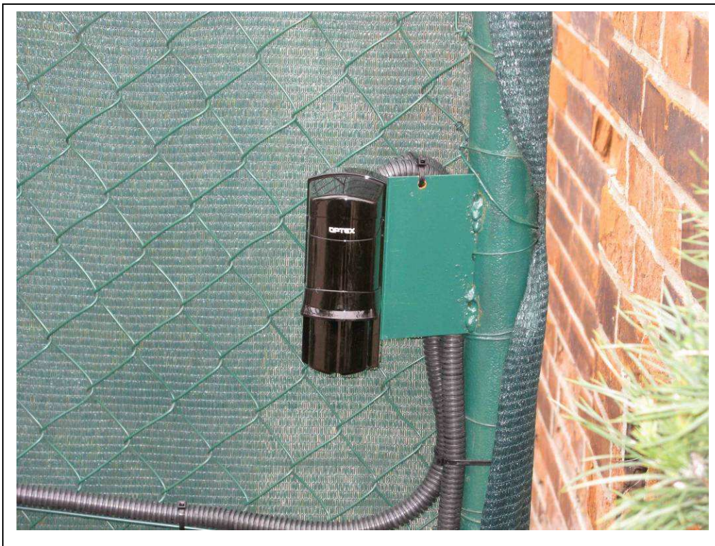
PI. 5 Západní vstup do areálu a umístění infrazávory
