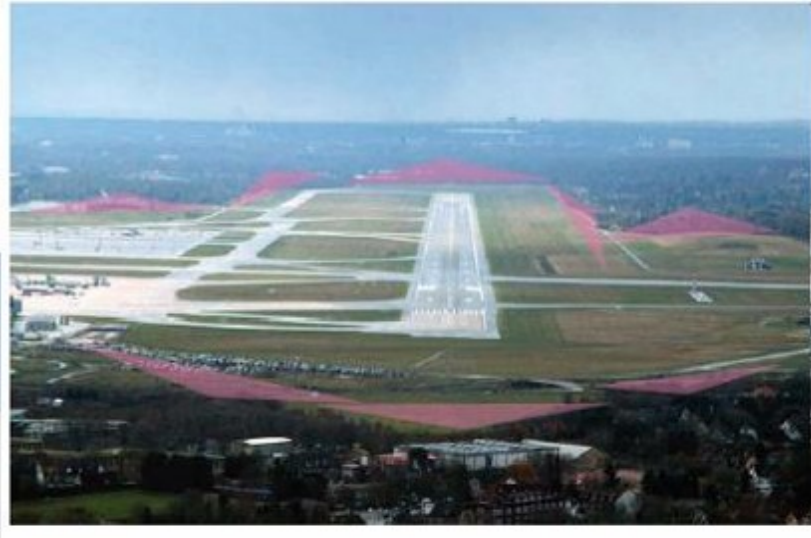
Obr. 36 Obvodová ochrana letiště. [10]
