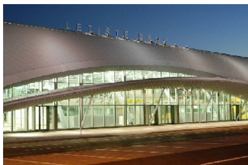
Obrázek č. 2 Nová odletová odbavovací budova terminálu postavená roku 2005 – 2006
