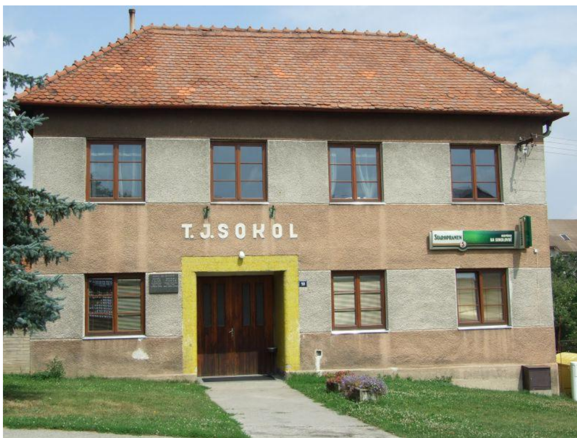
Obr. 2: vzhled budovy sokolovny v roce 2009
