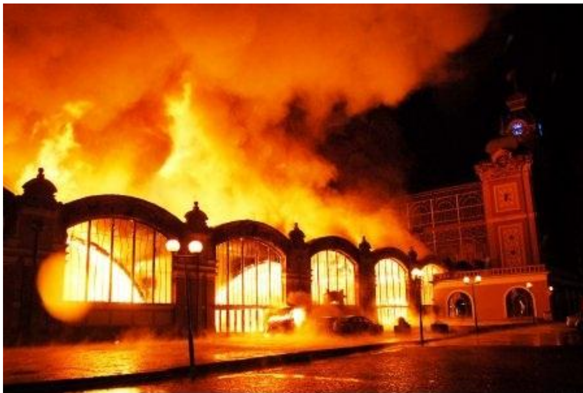
Obr. . 10. Požár levého kídla Průmyslového paláce
