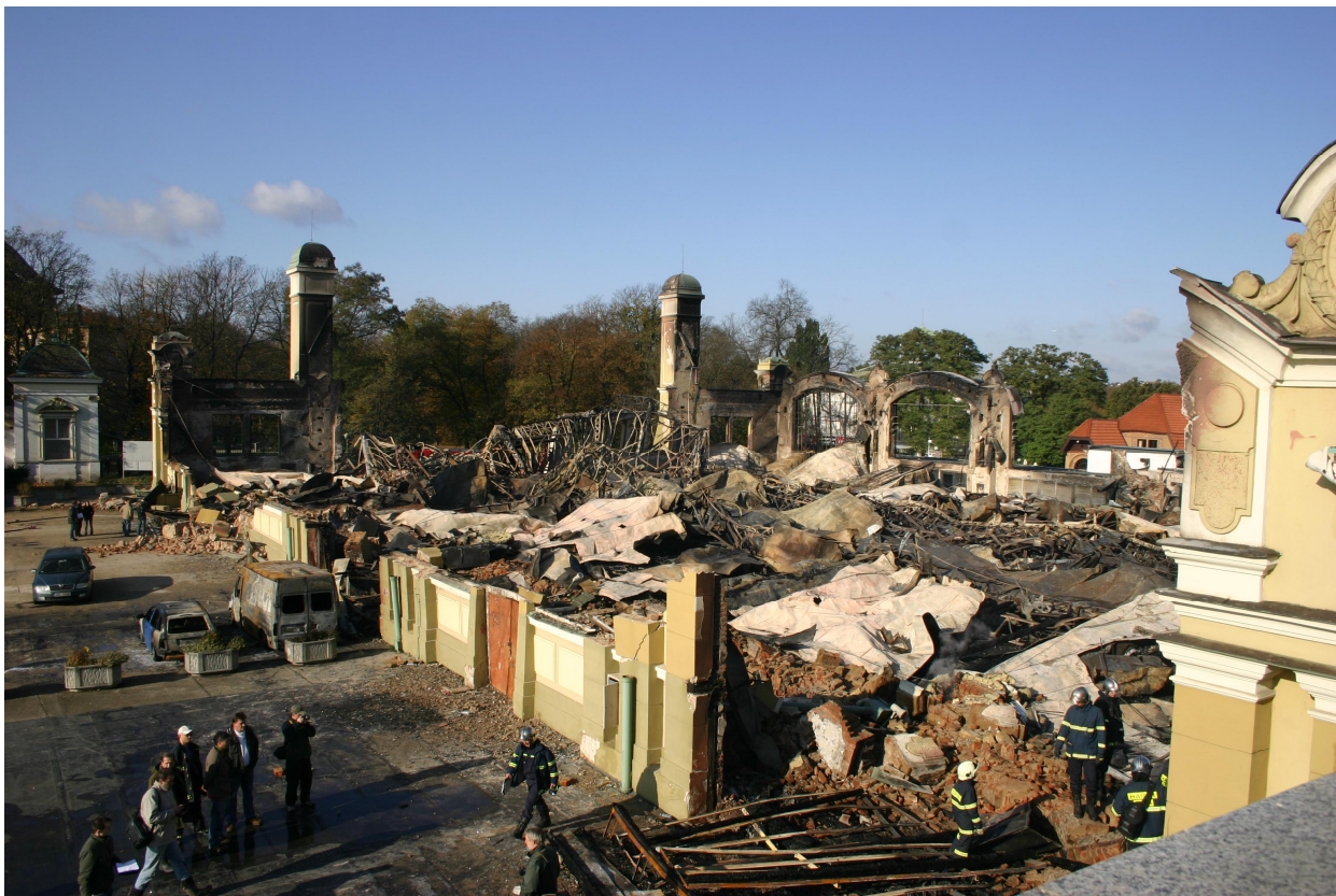
P VII. Ohledání místa po požáru Prmyslového paláce
