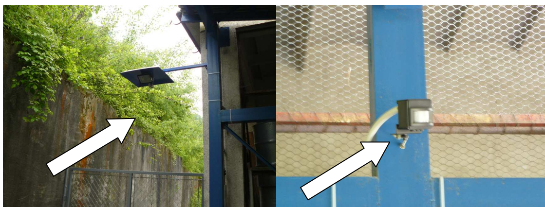
obrázek 18: Osvětlení s detektorem pohybu
