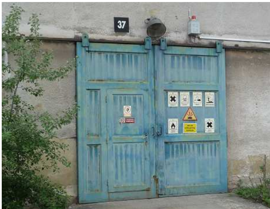
Obr. č. 12 Plechové dveře na budovách
