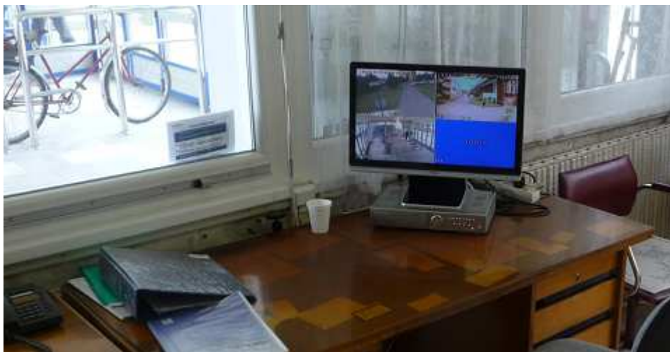
Obr. č. 13 Kamerový systém na hlavní vrátnici
