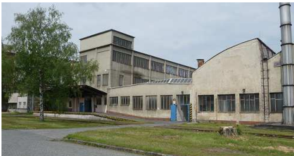
Obr. č. 11 Výrobní hala v areálu
