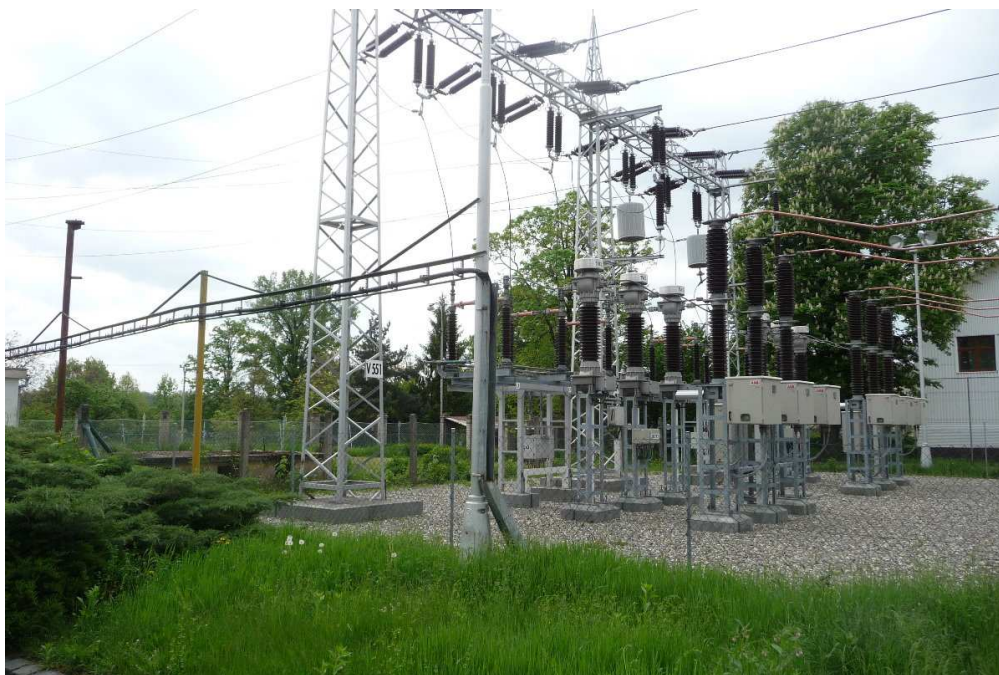
Obr. č. 18 Elektrické transformátory
