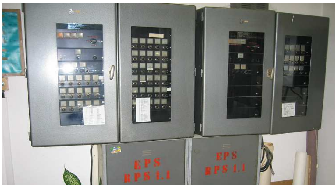
Obr. č. 14 Ústředna EPS v Hasičské zbrojnici
