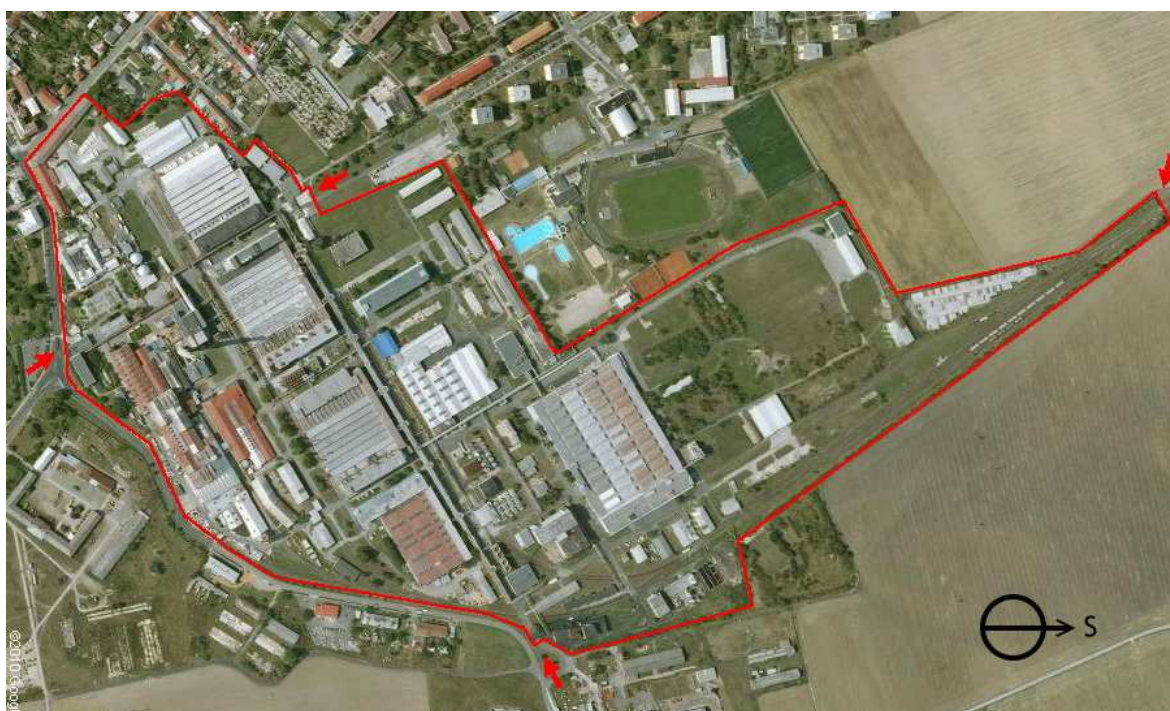
Obr. č. 17 Letecký snímek areálu
