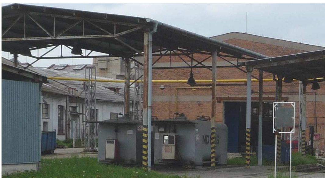
Obr. č. 35 Čerpací stanice v jihozápadní části areálu
