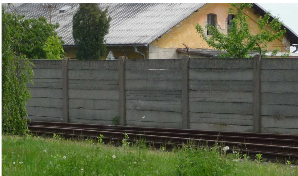
Obr. č. 9 Panelová stěna na jihozápadní části areálu
