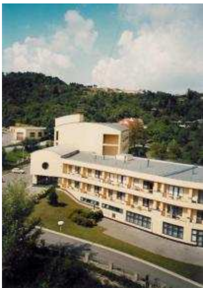
Obr. č. 1, 2. pohled na Domov seniorů Vychodilova
