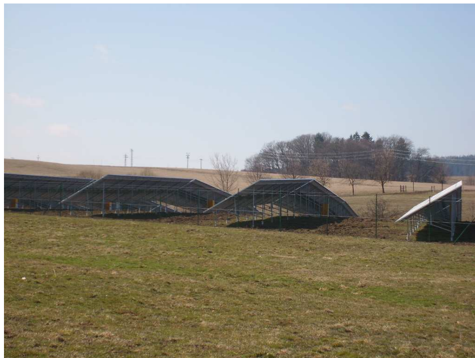
Obr. 15 Fotovoltaická elektrárna Slavičín ( Zdroj: vlastní )
