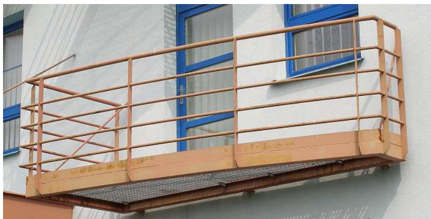
Obr. 34. Fotografie detailu balkónku budovy
