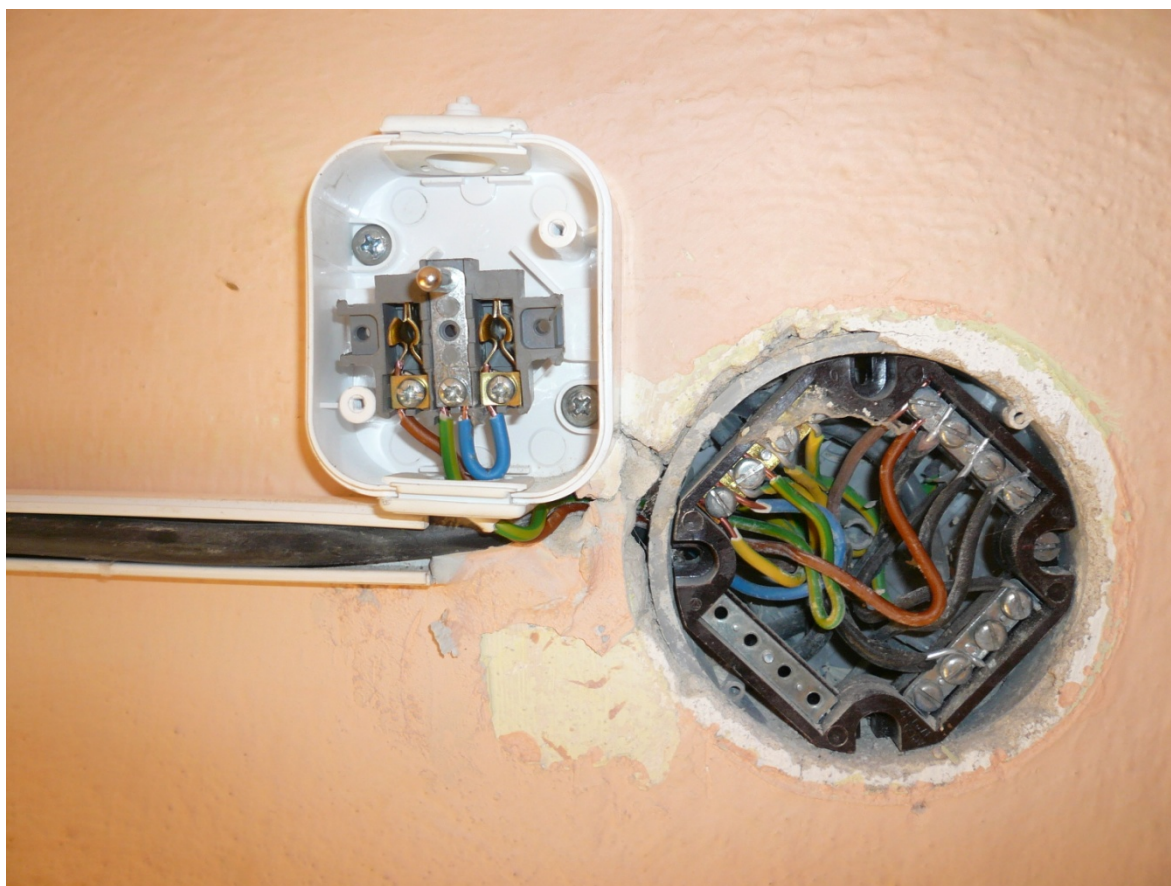
Obr. 38: Umístění a zapojení zásuvky 230V pro IP kameru
