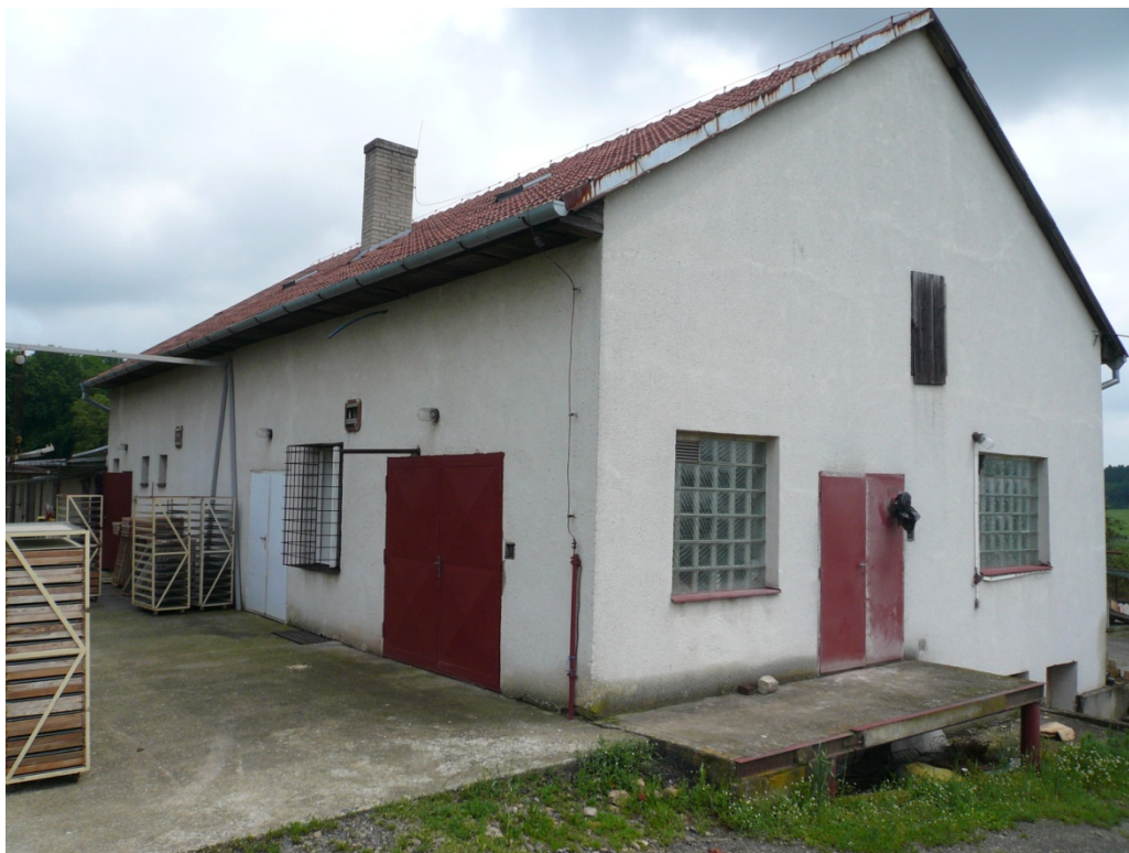
Obr. 49: Zado-boční pohled na bažantnici, zleva: hlavní dveře, líheň, elektrocentrála, sklad
