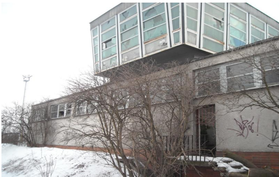
Nádraží ČD Otrokovice, objekt nefunkční hlásky.
