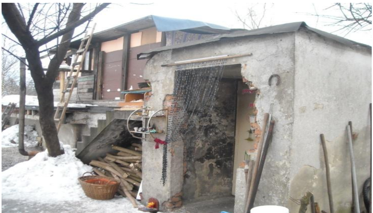
Vstup do podzemních obývaných prostor bunkru na ul. K. Čapka v Otrokovicích.
