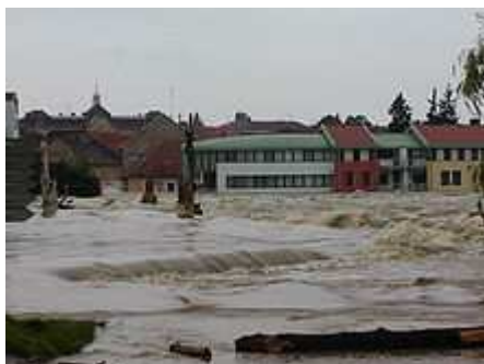
Obrázek 5: Most v Písku, který byl zcela pod vodou a byl i značně poškozen. [9]
