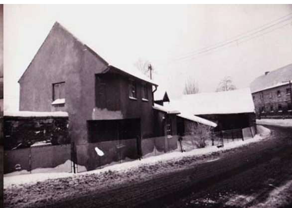
Obr. 5 : jihozápadní pohled z roku 1987
