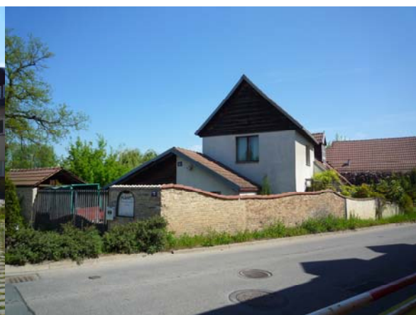
Obr. 7 : jihozápadní pohled z roku 2011
