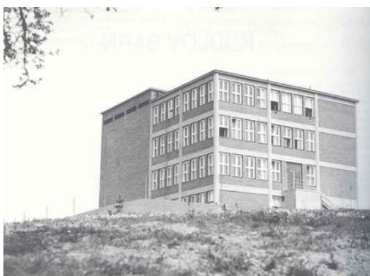
Obr.7 – Původní budova ateliérů
