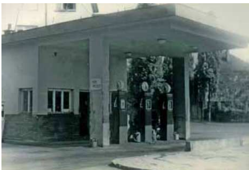
Čerpací stanice v Brně
