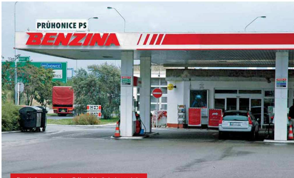
Exteriér čerpací stanice v Průhonících před rekonstrukcí...
