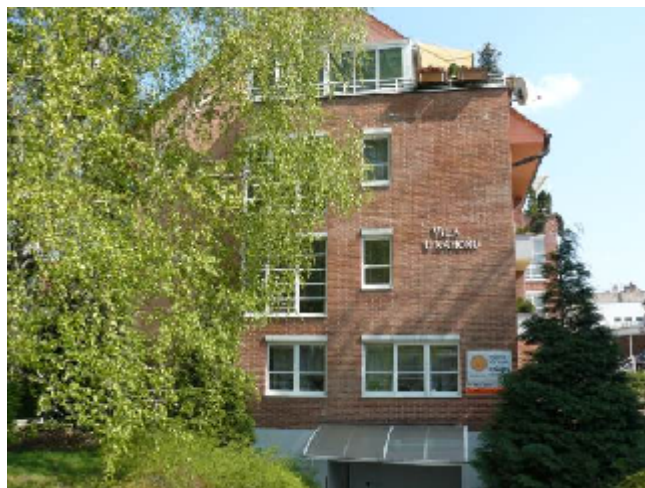
Obr. č. 3 Sídlo Intervenčního centra ve Zlíně
