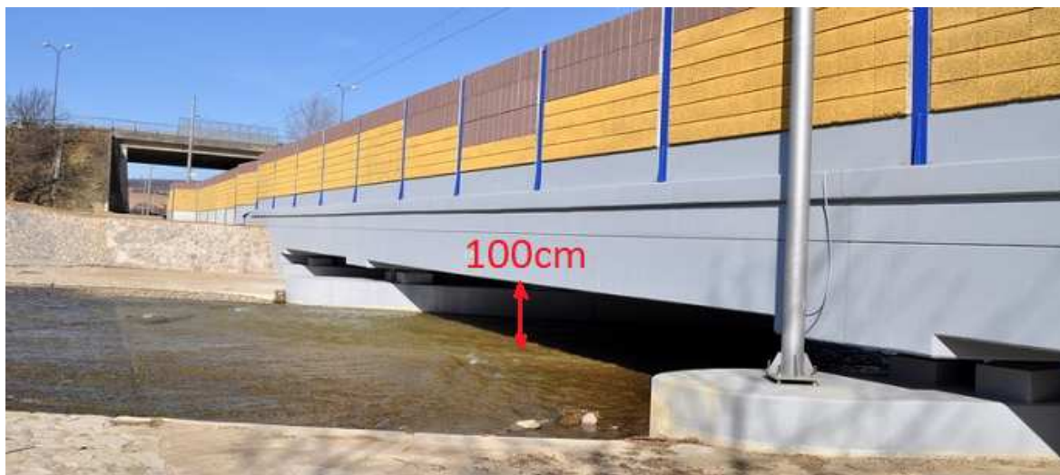
Obrázok 8: Nový železničný most na rieke Klanečnica [Zdroj: vlastný]
