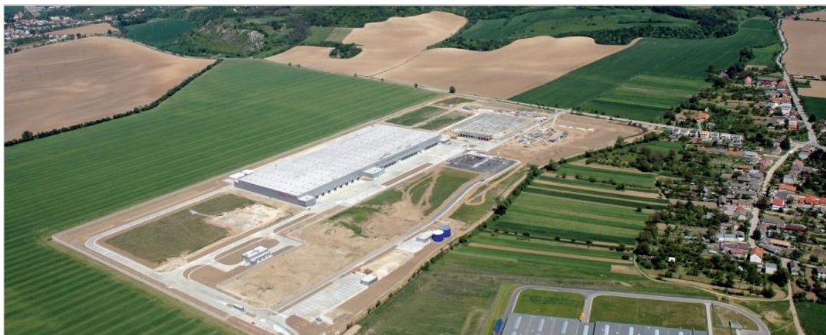
Obr. 3. Distribučné centrum Tesco Beckov a obec Kočovce – časť Rakoluby. [42]
