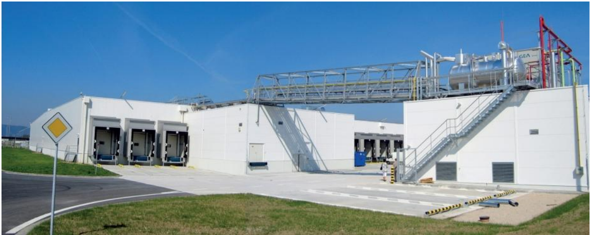
Obr. 4. Strojovňa chladienia DC Tesco Beckov. [42]
