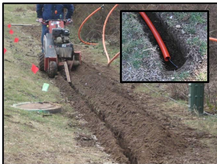
Obr. 10 Instalace vláknového optického systému [26]
