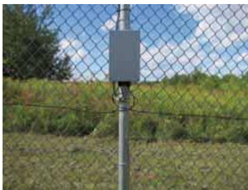
Obr. 8 Instalace mikrofonního kabelu [24]
