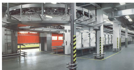
Obr. 9. Příjezdová rampa k balíkovému třidiči.
