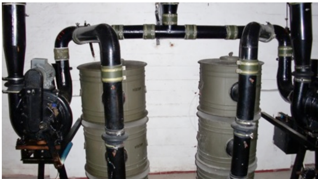
Obr. 14. Pohled na současný stav filtroventilačního zařízení
