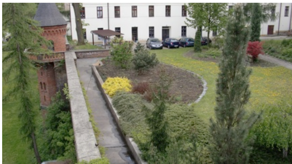
Obr. 10. Pohled na zemní nakrytí krytu
