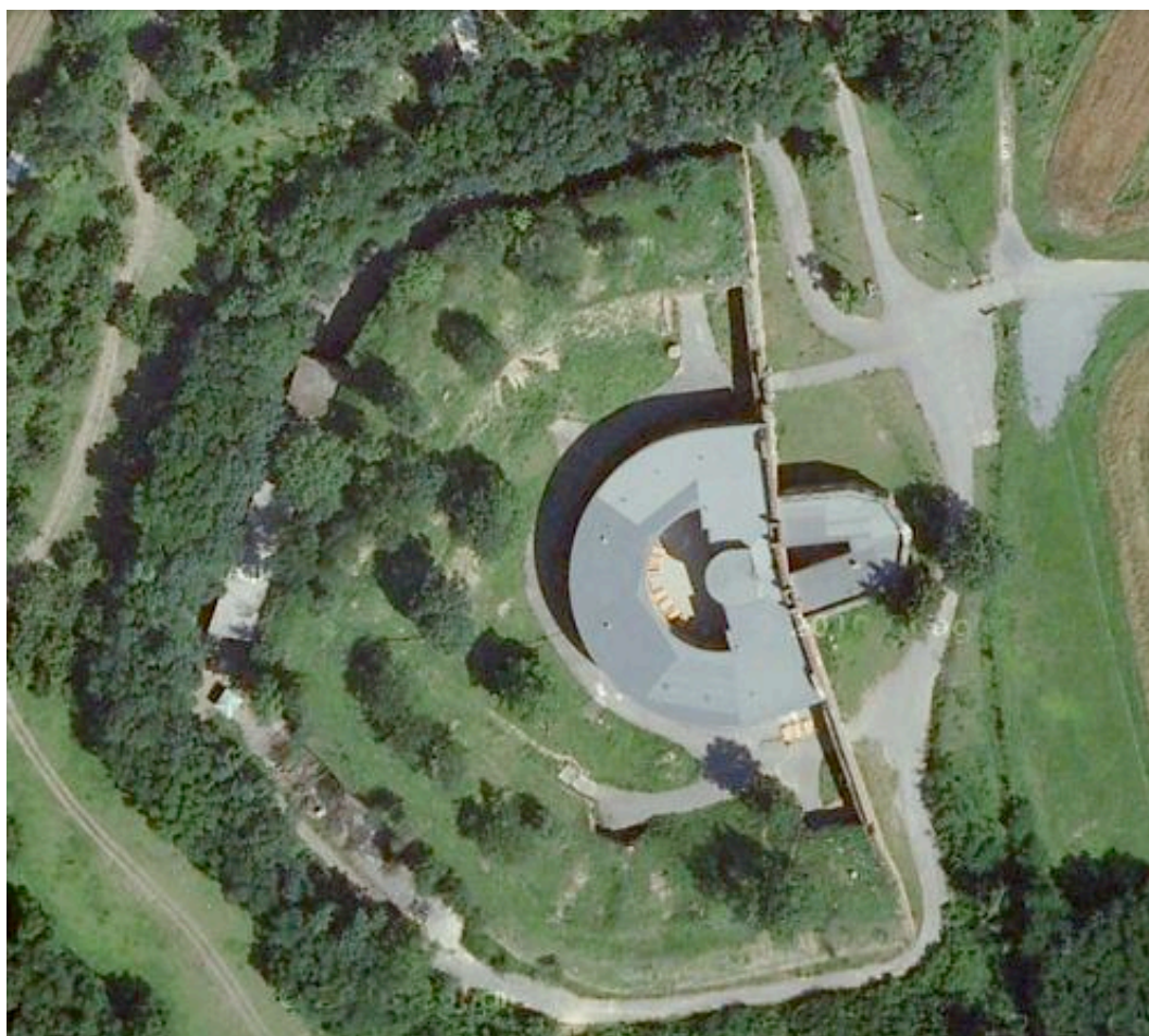
Obr. 20. Letecký pohled na současný stav fortu
