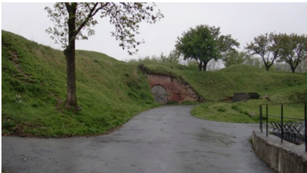
Obr. 22. Pohled na levý vstup do valů
