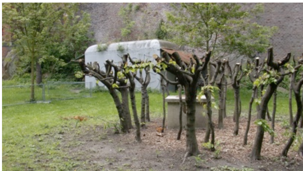
Obr. 14. Levý nasávací prostor krytý betonovou přístavbou
