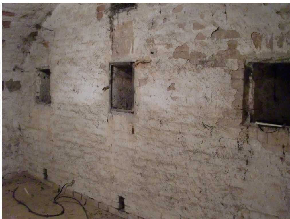
Obr. 28. eskarpová stěna kasematy se třemi střelnými otvory
