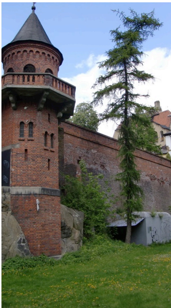
Obr. 9. Hradební těleso s betonovou přístavbou chránící vstup do krytu
