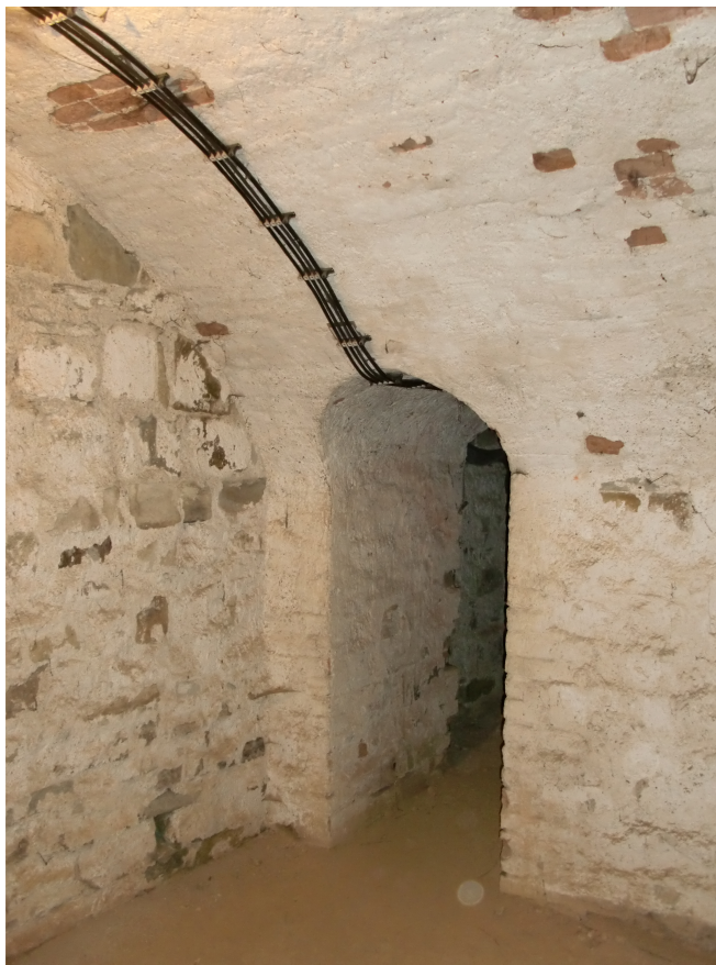
Obr. 26. Průchod mezi jednotlivými kasematami
