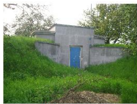
Podzemní vodojem Zlechov
