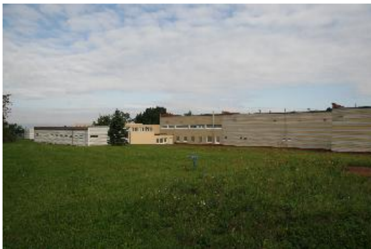
Obrázek 16 Úpravna vody Ostrožská Nová Ves
