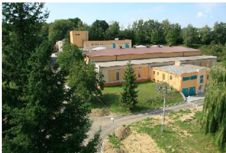
Obrázek 17 Úpravna vody Kněžpole
