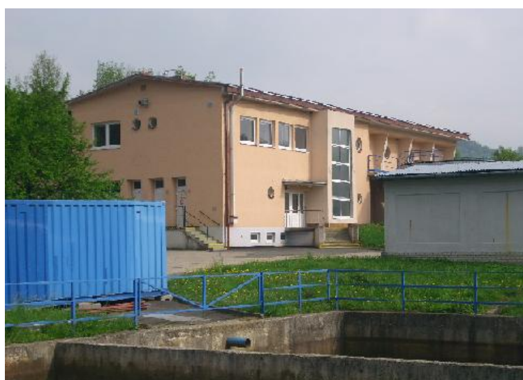
Obrázek 18 Úpravna vody Bojkovice
