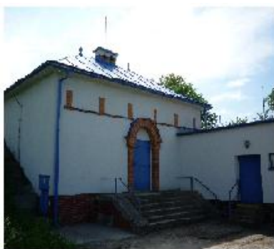
Nadzemní vodojem Mařatice
