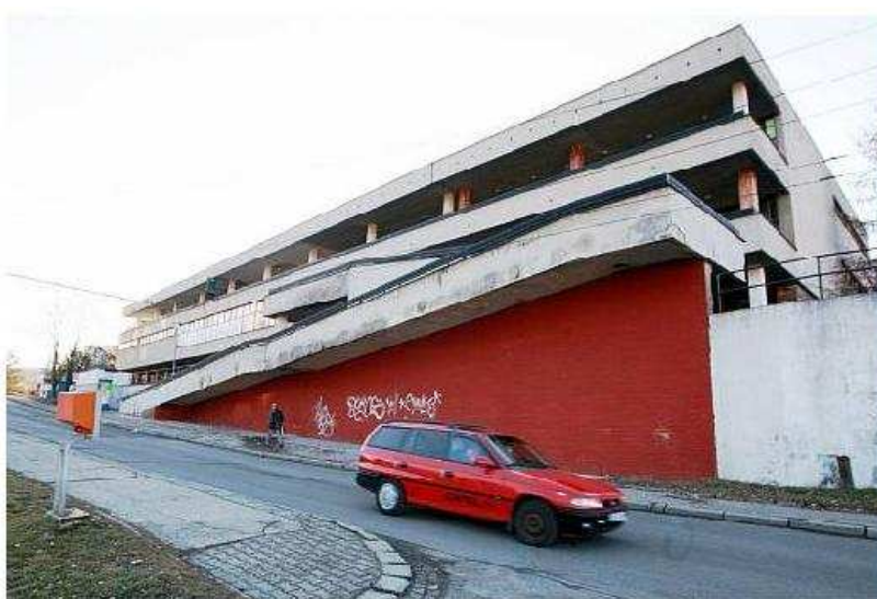
Obr. 2: Objekt chátrajícího bývalého nákupního centra Letná
