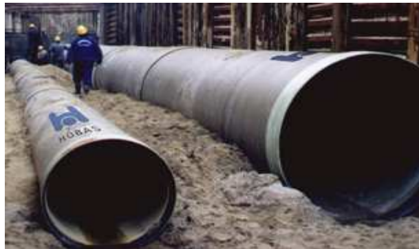
Obr.15 Sklolaminátové potrubí HOBAS pro kanalizaci [17]
