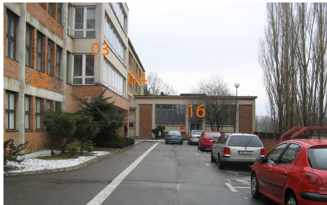
Obr.21: Objekt č. 02, 03, 04 a 16(pohled z hl.komunikace v areálu)
