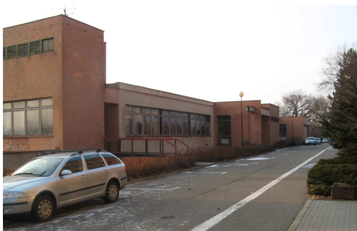
Obr.19: Objekt č. 29 - jídelna
