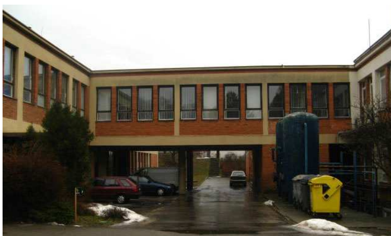
Obr.18: „Krček“ spojující objekt č.27 a 28
