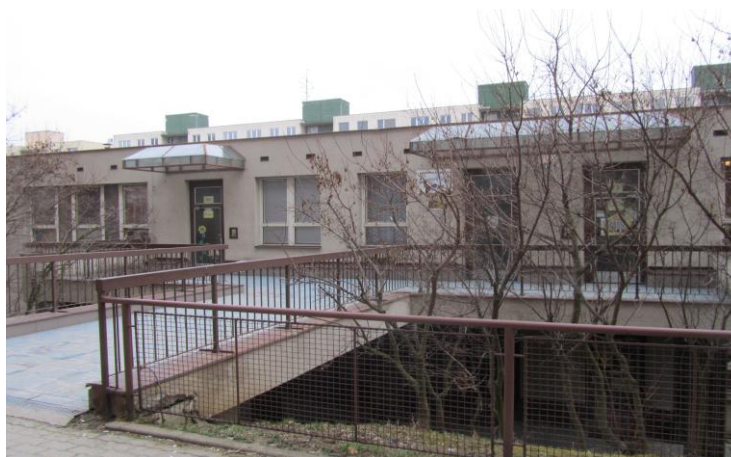
Obr. 3. Vchod do budovy MŠ Oblá
