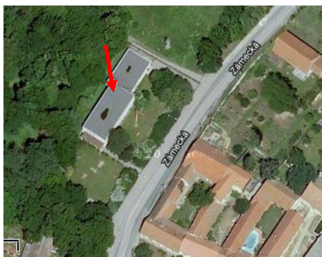
Obr. 6. Budova MŠ Troubsko [7]
