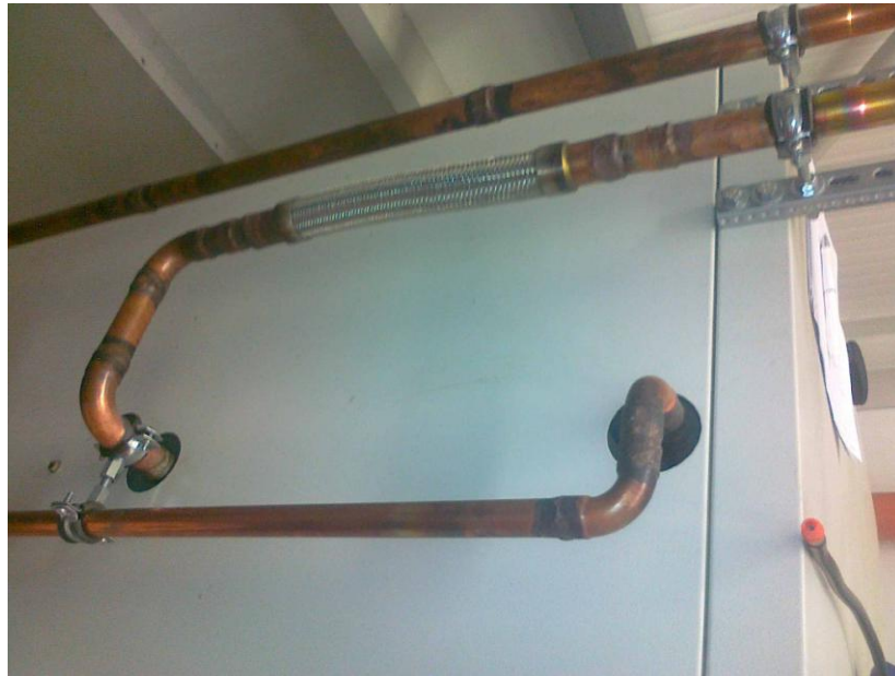
Obrázek 6 Výstupní potrubí do kondenzátoru
