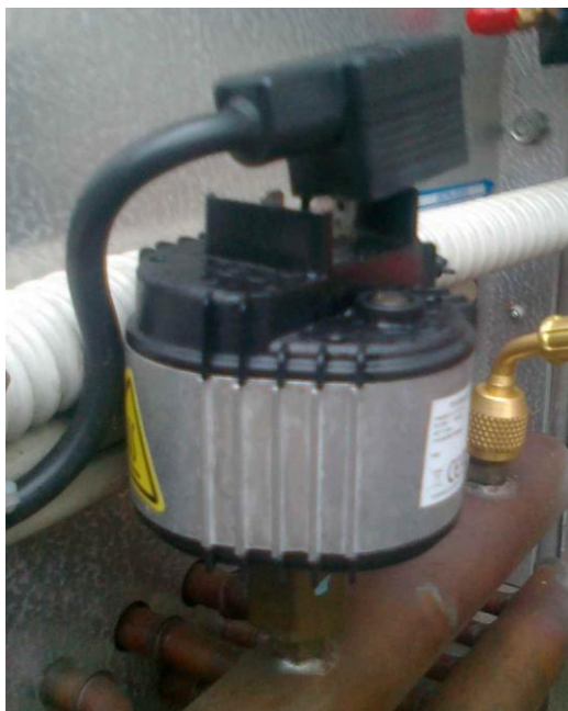
Obrázek 11 Regulátor otáček ventilátoru
