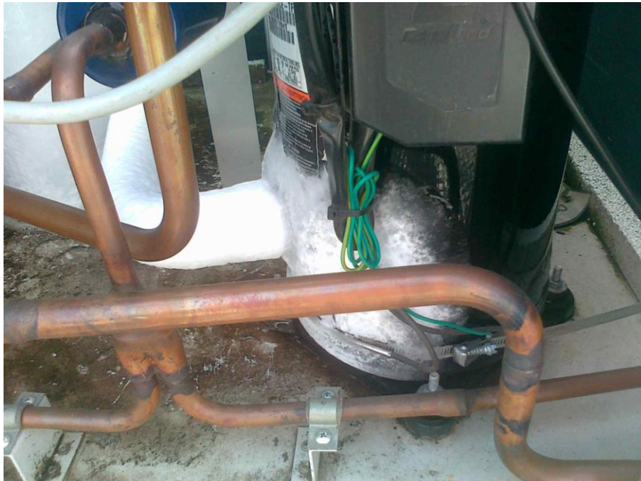
Obrázek 12 Zamrzlý kompresor
