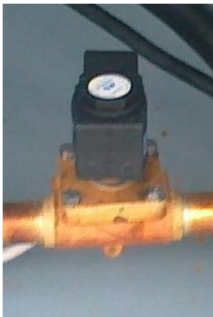
Obrázek 10 Elektromagnetický ventil – „Solenoid“
