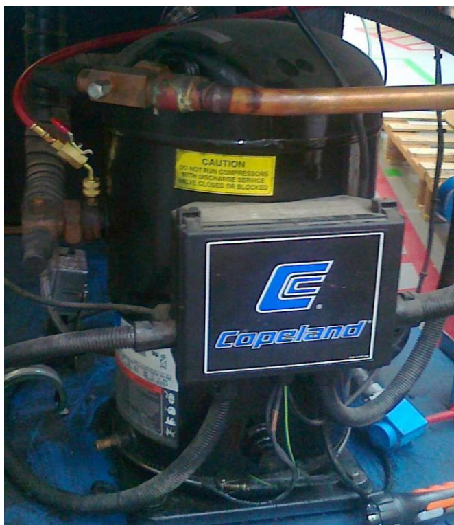
Obrázek 1 Spirálový kompresor „SCROLL“
