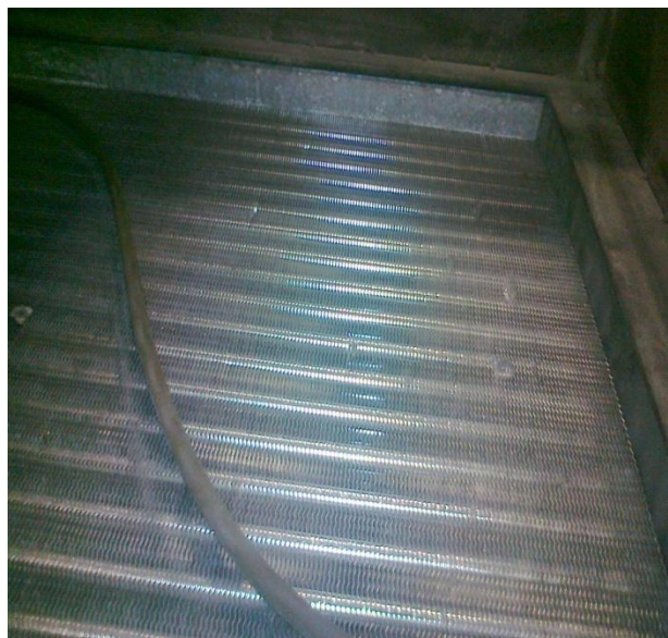
Obrázek 5 Výparník pro přímé chlazení umístěný uvnitř VZT
