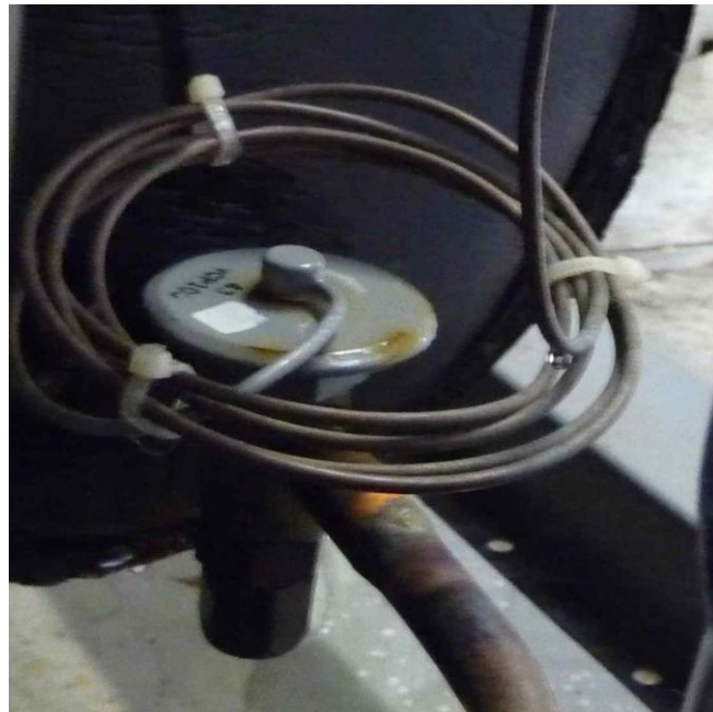
Obrázek 4 Automatický expanzní ventil
