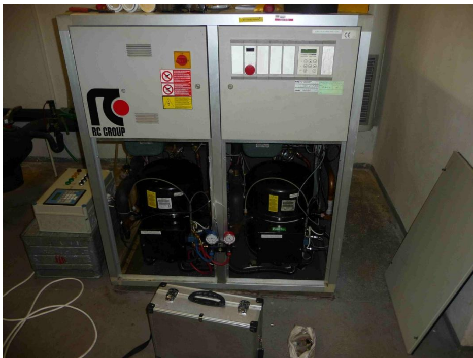
Obrázek 16 chladicí zařízení „RC GROUP – typ 120.E2 G2“ s připojeným průmyslovým regulátorem
