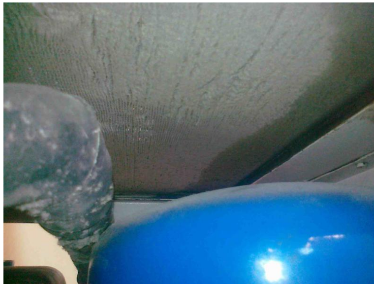
Obrázek 30 Znečištěný kondenzátor
