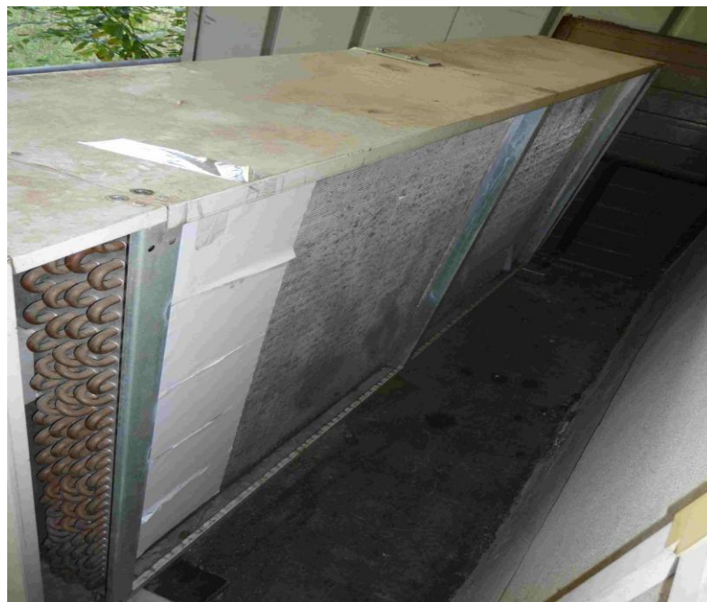
Obrázek 31 Zmenšení plochy kondenzátoru pomocí papíru
