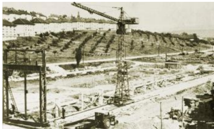
Obrázek 7 – Výstavba areálu továrny (Česká zbrojovka, 2009 – 2012a)
