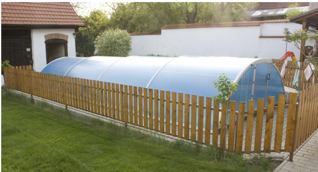
Obrázek 5 Správné zabezpečení bazénu
