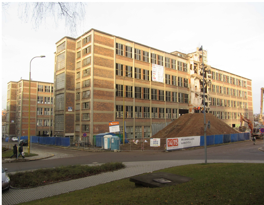
Obrázek 7: Budova č. 14, Zdroj: vlastní, 2. 1. 2012
