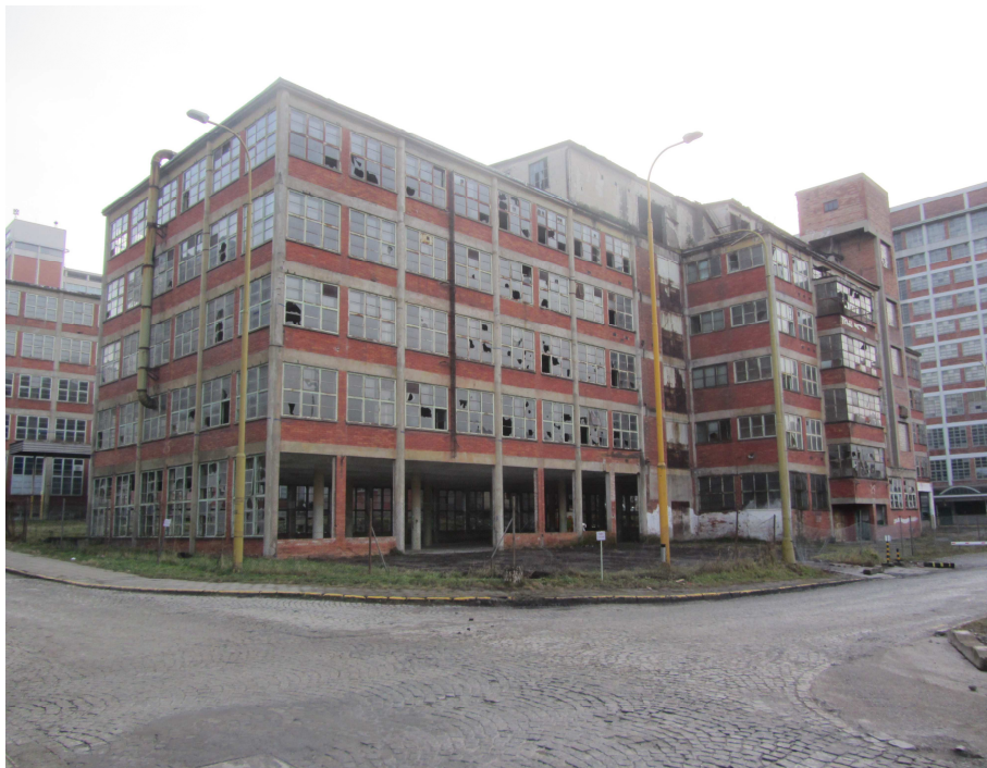
Obrázek 4: Budova č. 25, Zdroj: vlastní, 2. 1. 2012
