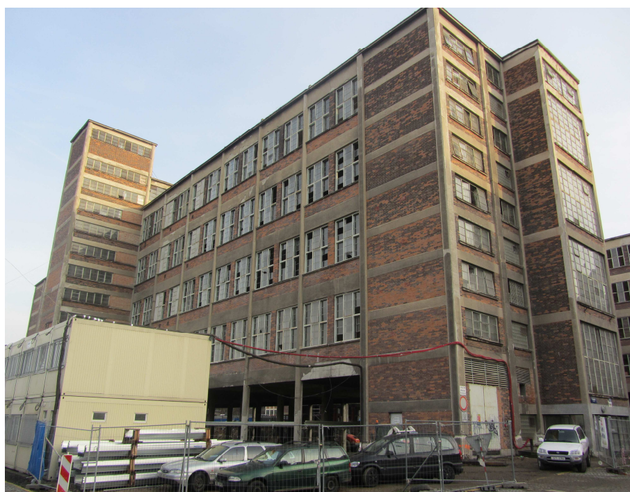
Obrázek 6: Budova č. 15, Zdroj: vlastní, 2. 1. 2012
