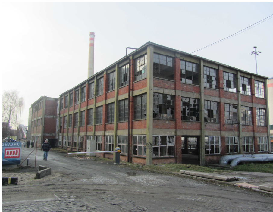
Obrázek 5: Budova č. 24, Zdroj: vlastní, 2. 1. 2012
