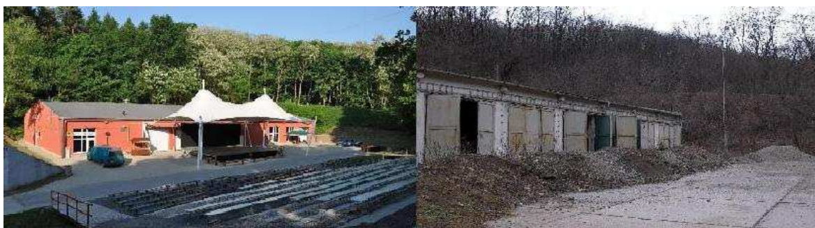
Obr. 4 Zrekonstruovaná hala z bývalého skladu automobilové techniky [17]
