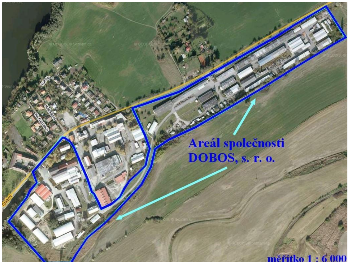
Obrázek 1. Letecký pohled na areál DOBOS, s. r. o. [28, vlastní]
