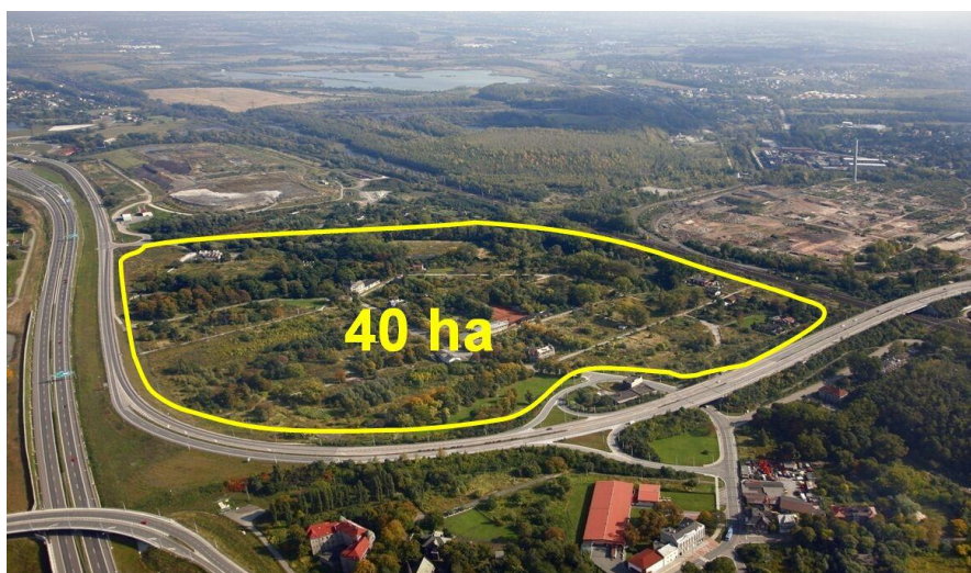
Obrázek 7 - Letecký snímek sociálního BF Hrušov (zdroj: www.ostrava.cz , ©2011)
