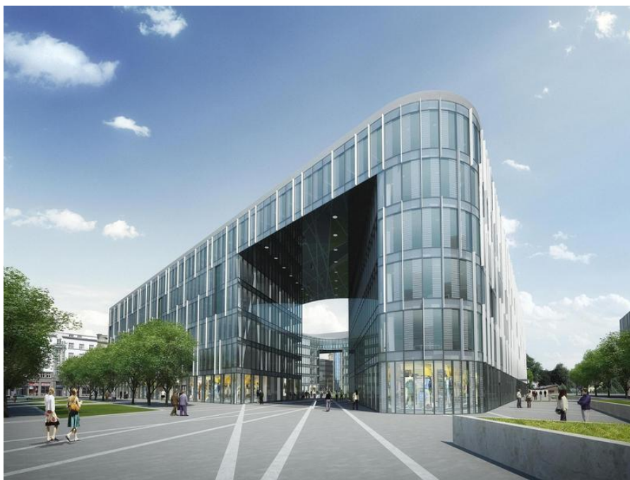
Obrázek 6 - Administrativní budova Nová Karolína Park (zdroj: www.stavbaweb.cz , ©2011)
