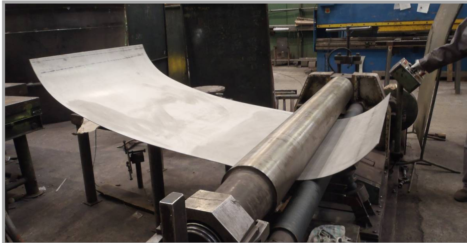
Obr. 25 Skružování válcového pláště – nakružení konců
