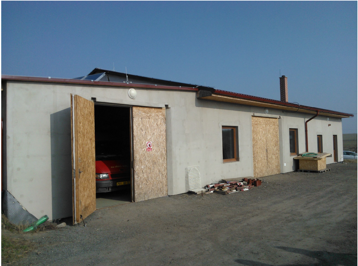
Obr. 6. Provozovna firmy Solar Plus
