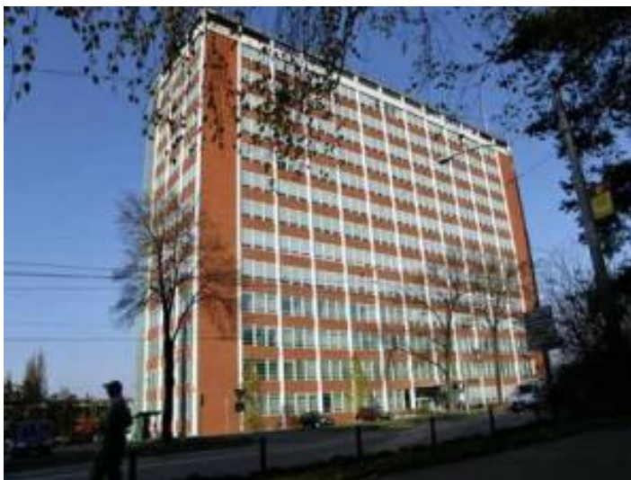
Obrázek 30 – Budova krajského úřadu, Zlín, zdroj: archiv ©Mediafaxfoto.cz
