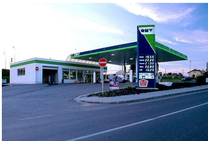
Obrázek 28 – Čerpací stanice OMV, Staré Město u Uherského Hradiště,
