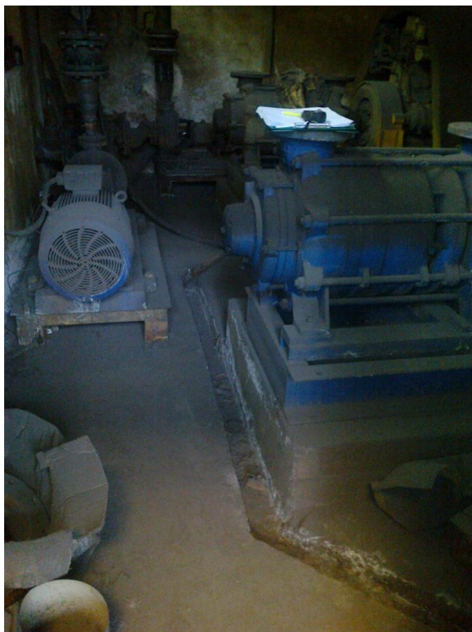
Obr. 113. Pohled do stávajícího objektu – čerpadla
