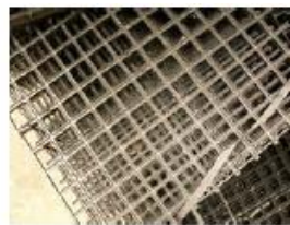
Obr. 32. Chladicí výplně
