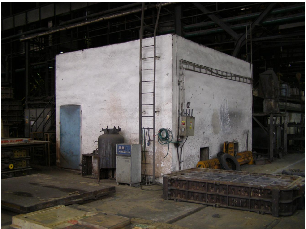
Obr. 102. Objekt původní havarijní čerpací stanice
