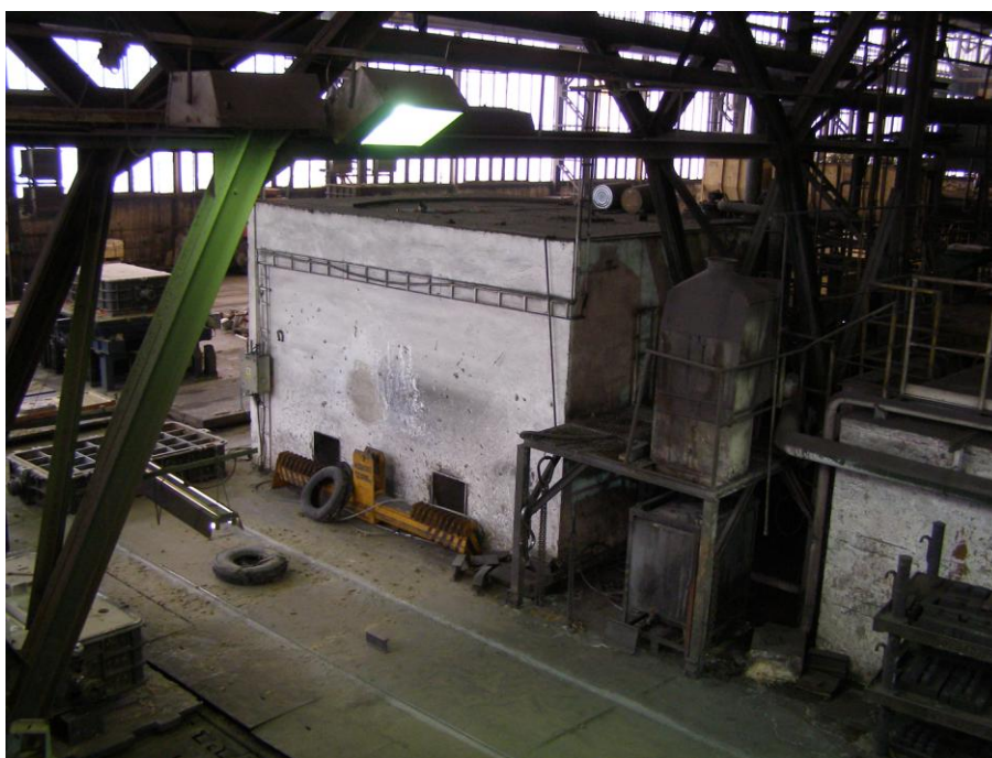
Obr. 103. Horní část objektu
