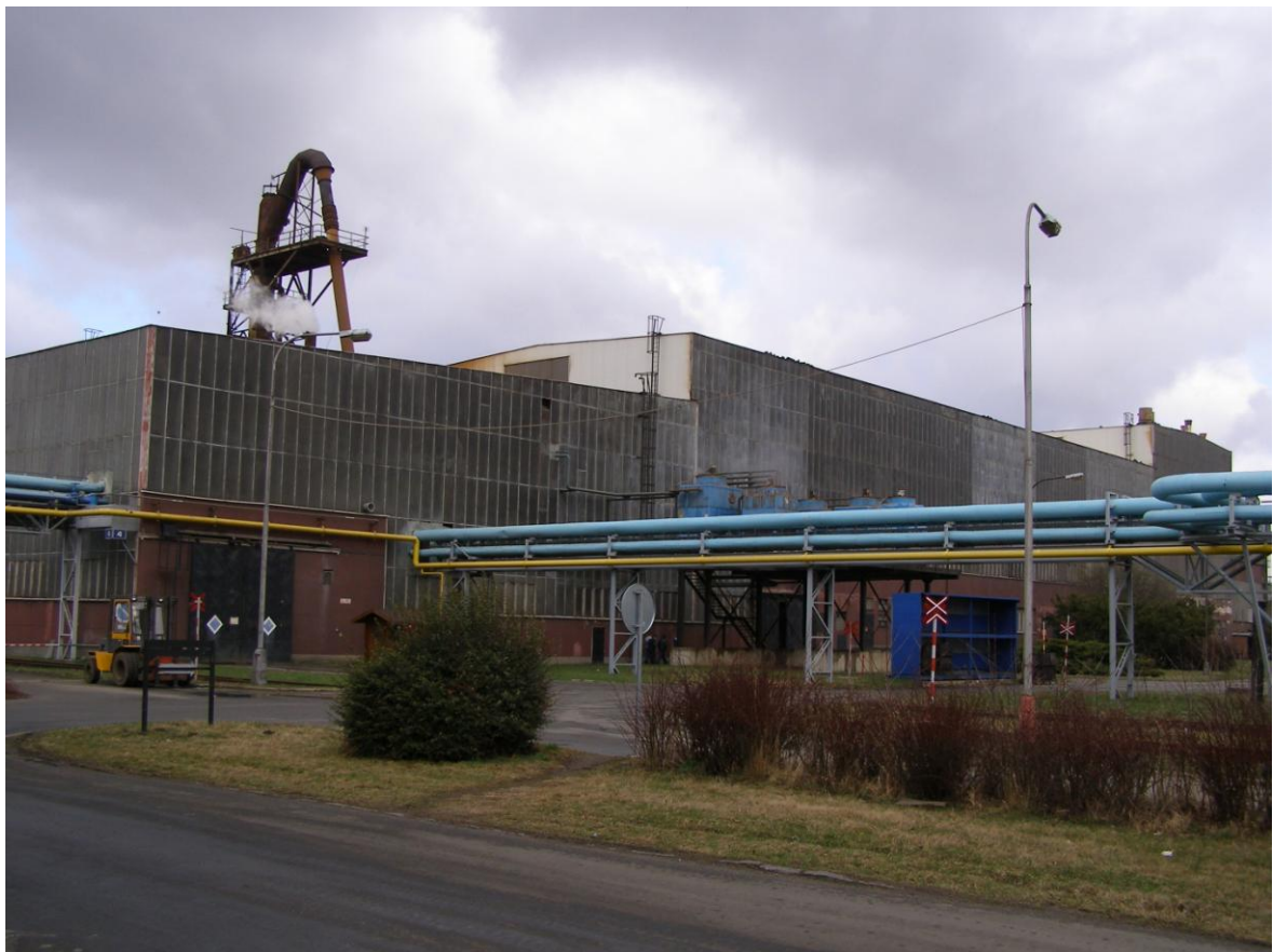
Obr. 2. Slévárna ZPS a. s.
