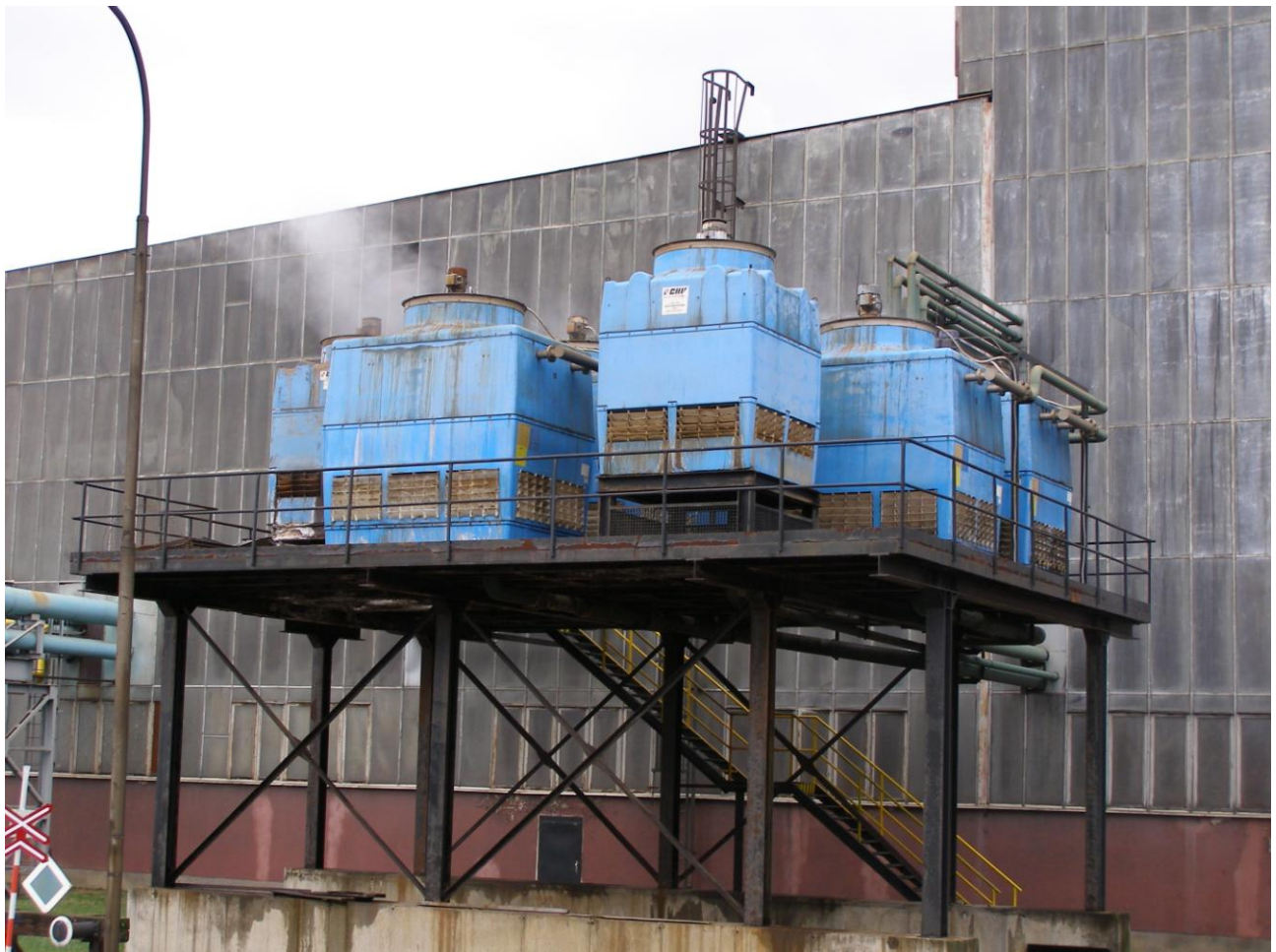
Obr. 35. Umístění chladicích věží vedle haly slévárny
