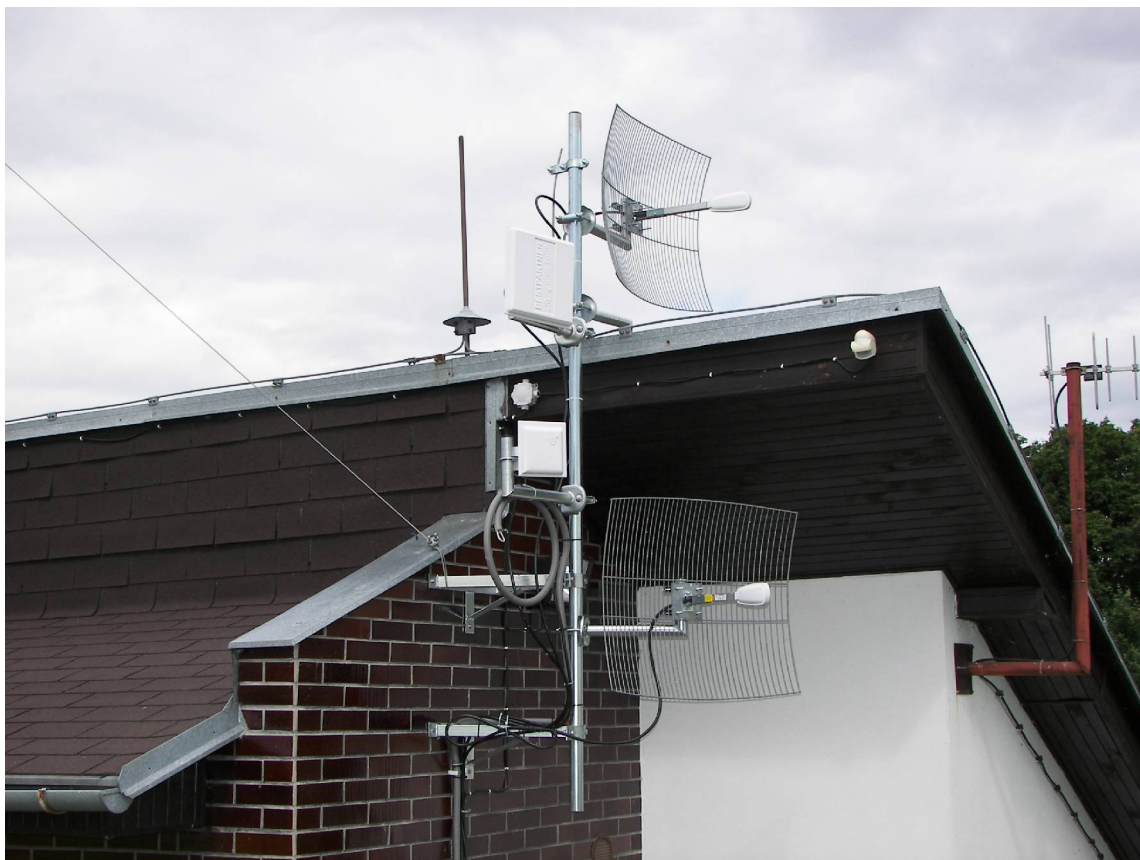
Příloha P III: Jeden z realizovaných vysílačů v pásmu 2,4 a 5 GHz
