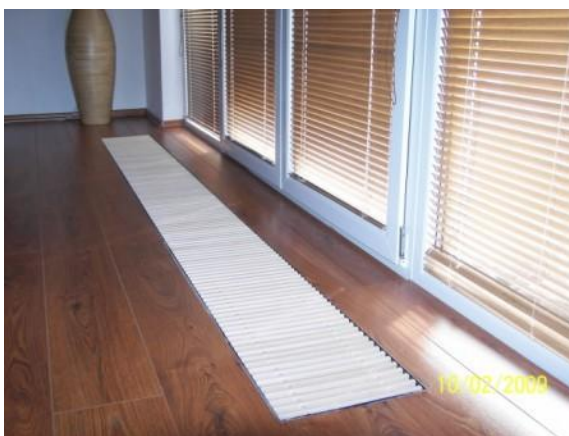
Obr. 7 Fan-coil umístěný v podlaze
