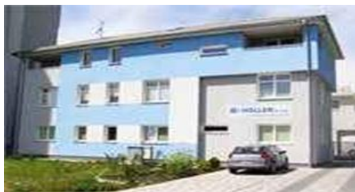
Obr. 11. Centrála HOLLEN s.r.o. [18]
